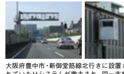
大阪府豊中市・新御堂筋線北行きに設置されていたHシステムが撤去され、同一支柱にLiHシステムが取り付けられました。速度計測用のLiDARユニットは本体ユニットの手前、約20mの壁面に設置されています。
