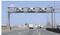
阪神高速限定の元祖Hシステムは、写真のタイプの他に丸いレーダーがむきだしになったタイプもあります。現在撤去進行中!!
